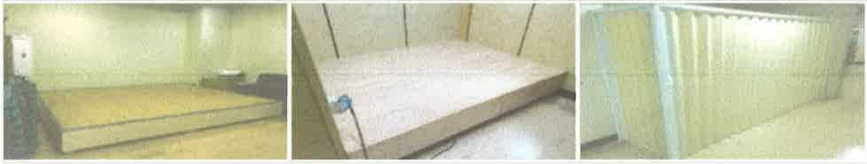
휴게실 휴게 평상 설치 및 자바라 설치
